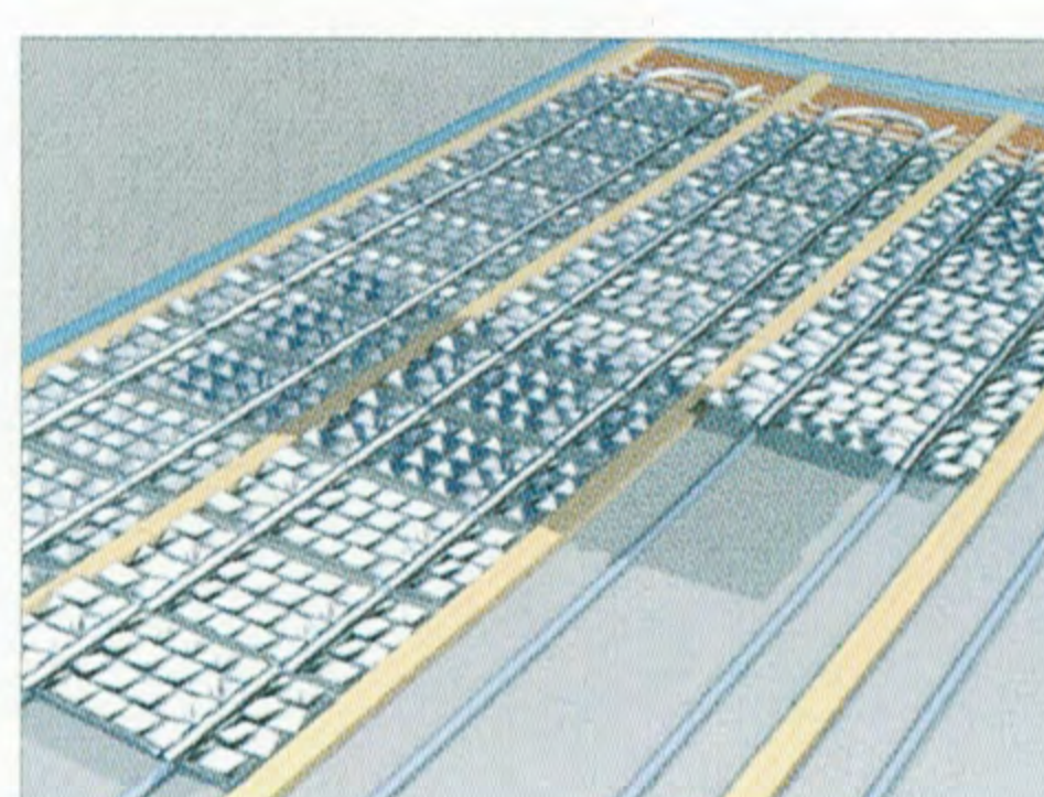
8) Verlegen der PYD®-ALU-Thermoleitbleche
