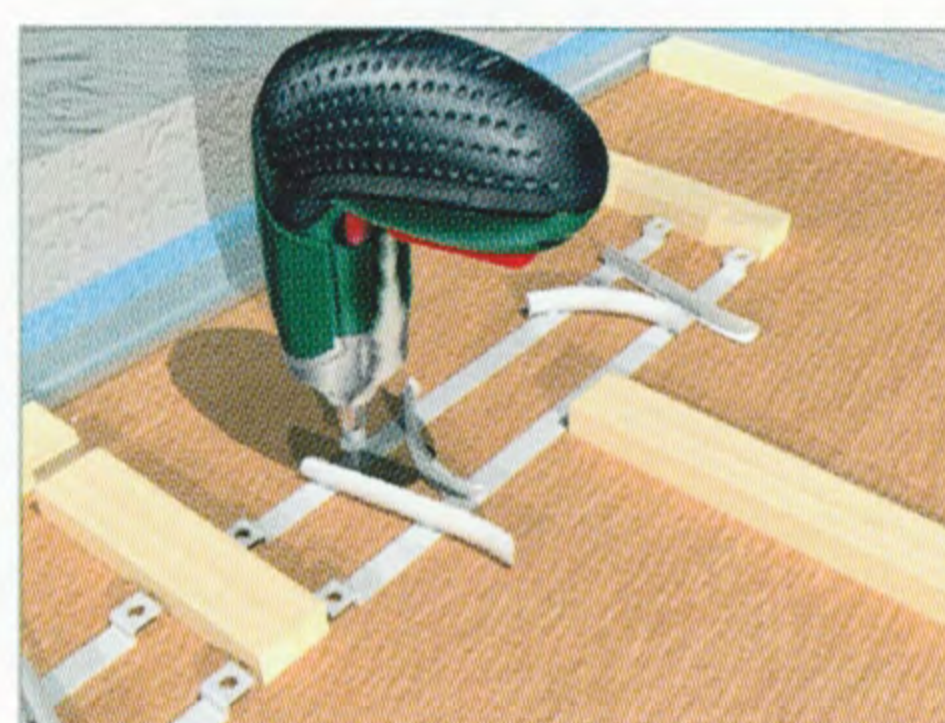
7) Montieren des PYD®-Systemrohres
